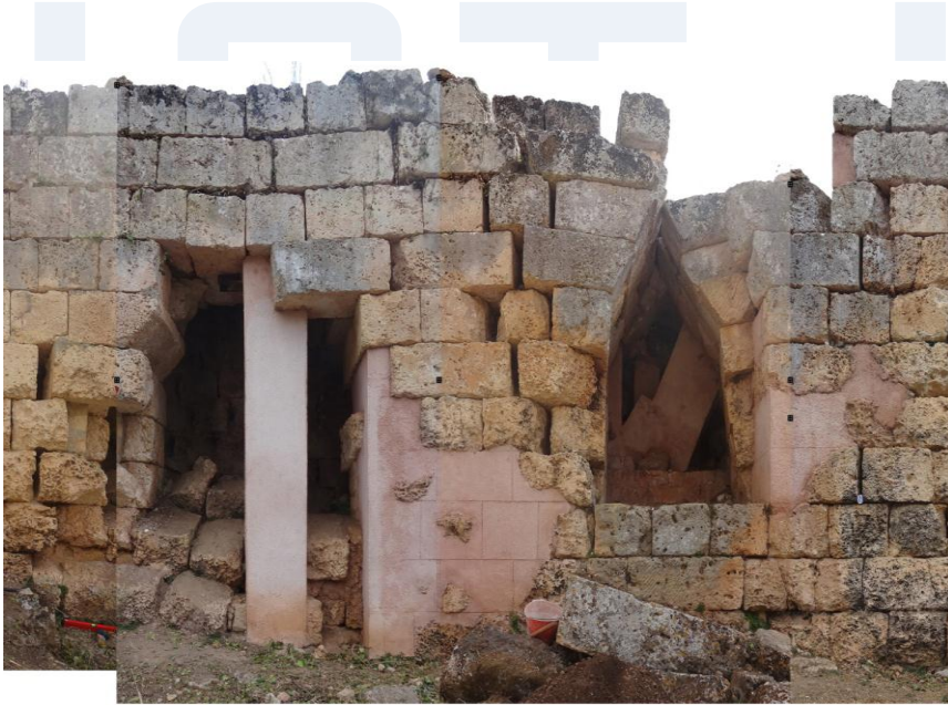
الشكل 16- استخدام الاسمنت والخرسانة في الترميم
