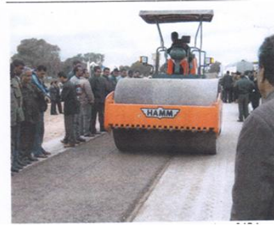
الشكل (5) عملية الدمك الإبتدائي [6].
