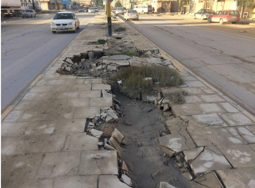
شكل رقم 6: هبوط أرضي في منتصف شارع أنتلات
