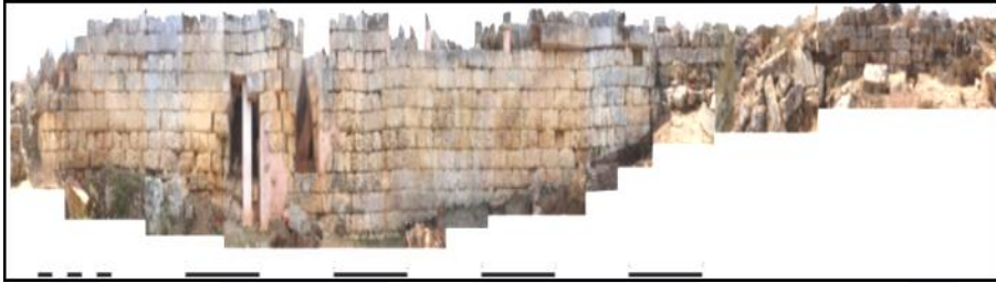
الشكل 11- الواجهة الأمامية للجدار، ونلاحظ فتحات الأروقة V1, V2
