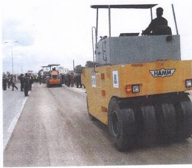
الشكل (6) عملية الدمك النهائي [6].
