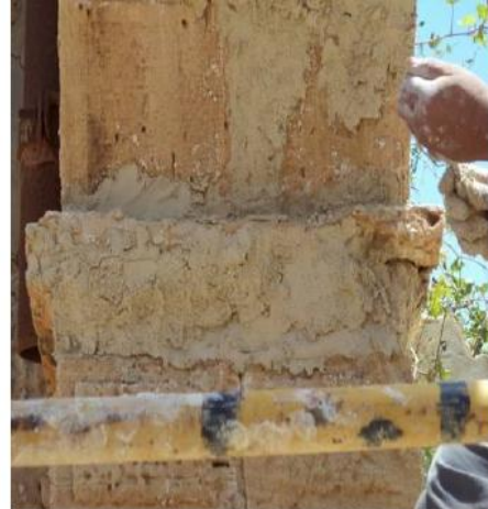
شكل 8- استخدام مونة الطين والطفلة في ترميم كنيسة سوسة
