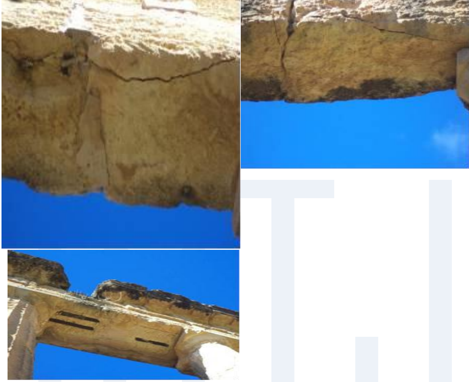
شكل 3- استخدام أسياخ الحديد الغير معالج لمقاومة الصداً في عمليات الترميم
