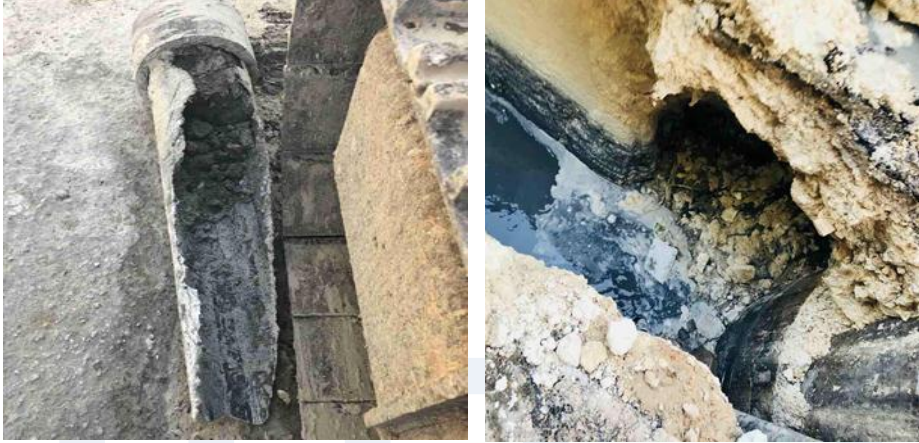
شكل رقم (2): تسرب مياه الصرف الصحي نتيجة لتلف الانابيب وتأثيرها على الطبقات المجاورة.
