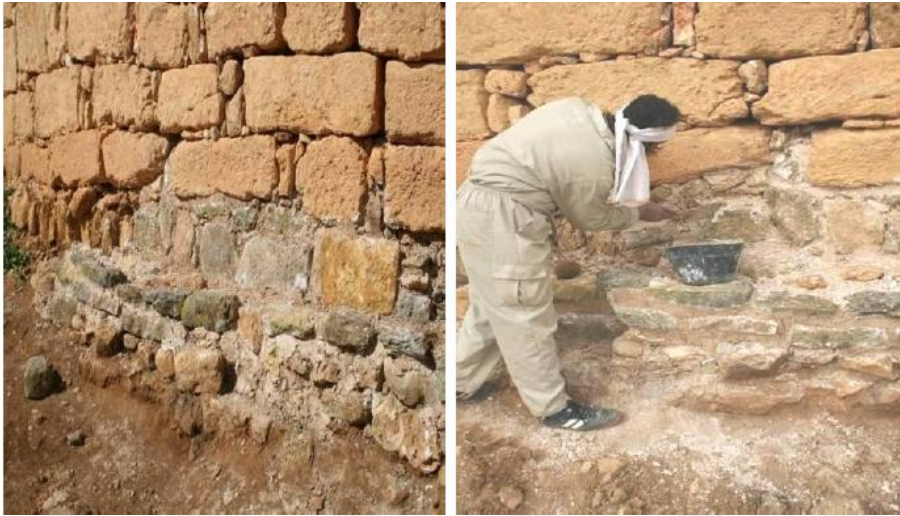
شكل 9- استخدام عجينة القرميد بقلعة تريت
