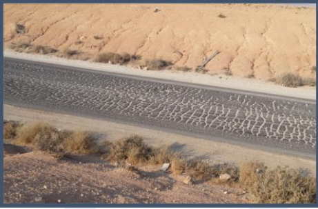
شكل (2): أضرار الرصف على طريق مخيلي - النوار
