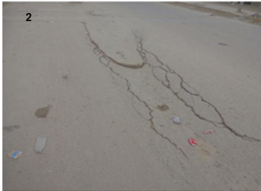
شكل رقم (7): بعض الهبوطات الارضية بمدينة أجدابيا: 1. بداية شارع الوفاق 2. منتصف شارع الوفاق 3 بداية شارع الوفاق (مفرق العابدية).
