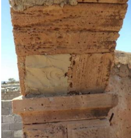
شكل 8- استخدام مونة الطين والطفلة في ترميم كنيسة سوسة
