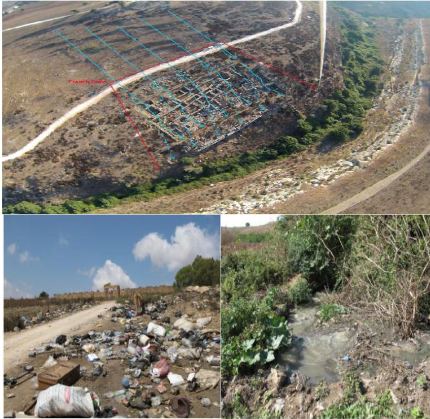
شكل15- مشاكل مياه الأمطار و الصرف الصحي والمخلفات
